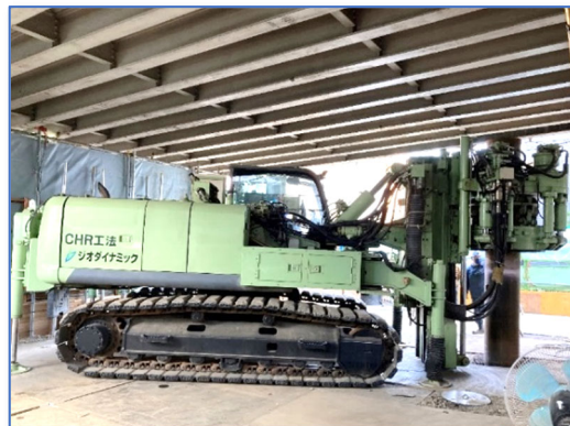
埼玉県（跨線橋）
