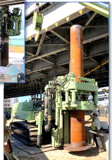
横浜市（跨線橋）
